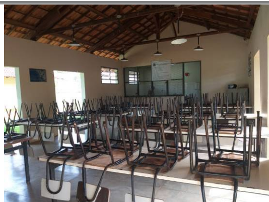
Foto 07: Vista da cantina com paredes revestidas com camada pictórica na cor branca e sem forro, permitindo vista da estrutura de madeira do telhado. Autoria: Gabriela Macedo Data: 03/11/2020
