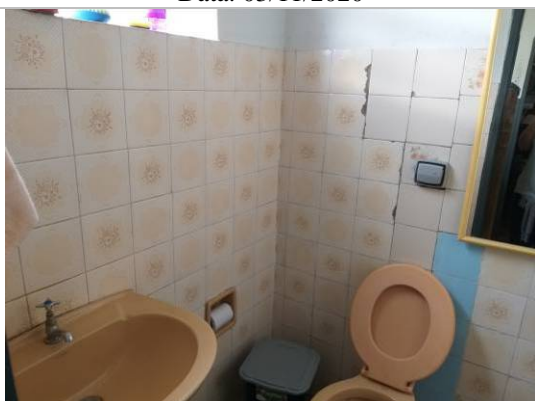
Foto 08: Vista parcial da instalação sanitária com cerâmica à meia altura. Notam-se perdas de peças e substituições por cerâmicas diferentes.
