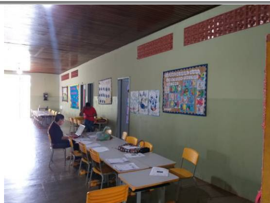
Foto 09: Corredor principal com detalhe da ventilação das salas de aula em cobogó cerâmico. Autoria: Gabriela Macedo Data: 03/11/2020
