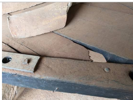
Foto 07: Detalhe da mesa com perda pontal de parte, fissura da peça de madeira, sinal de oxidação da ferragem e acúmulo de sujidade. Autor: Gabriela Macedo Data: 03/11/2020
