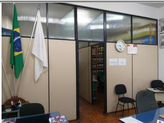
Foto 06: Divisória naval na cor bege com estrutura pintada na cor preta e bandeira transparente.
