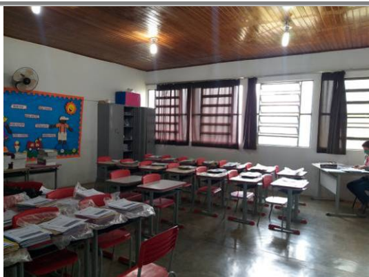
Foto 08: Uma das salas de aula. Forro de madeira, paredes recebem pintura na cor verde e piso de cimento queimado. Autoria: Gabriela Macedo Data: 03/11/2020
