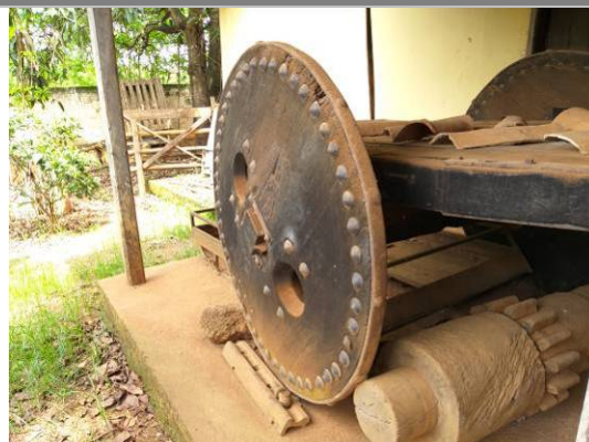
Foto 05: Vista da roda esquerda, nota-se escurecimento da madeira e ressecamento. Autor: Gabriela Macedo Data: 03/11/2020
