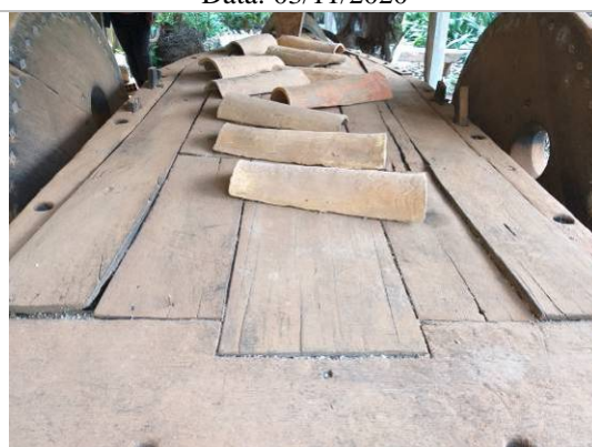
Foto 09: Vista da mesa que apresenta falta de calefação entre as peças, fissuras, acúmulo de sujidades e escurecimento de partes. Data: 03/11/2020
