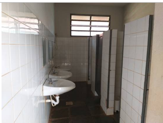
Foto 08: Vista parcial da instalação sanitária com revestimento cerâmico branco a meia altura e piso de ardósia. Autoria: Gabriela Macedo Data: 03/11/2020
