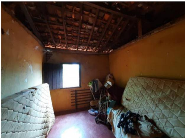
Foto 07: Um dos cômodos da edificação, notando-se a esquadria de madeira com uma folha de abrir, o piso de cimento queimado e a estrutura aparente da cobertura.
