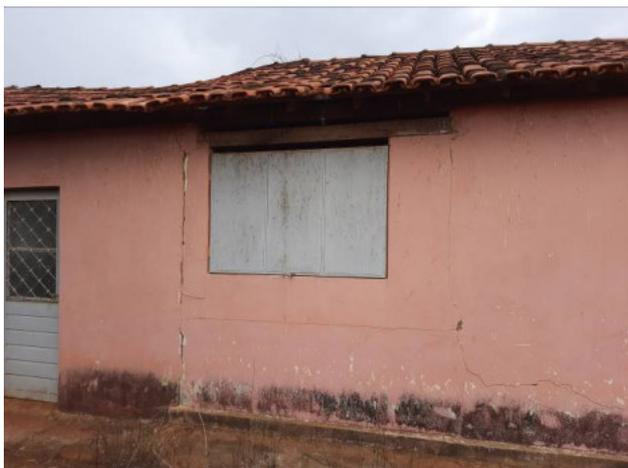
Foto 05: Detalhe de um dos vãos do Salão Comunitário, com fechamento com chapa metálica.
