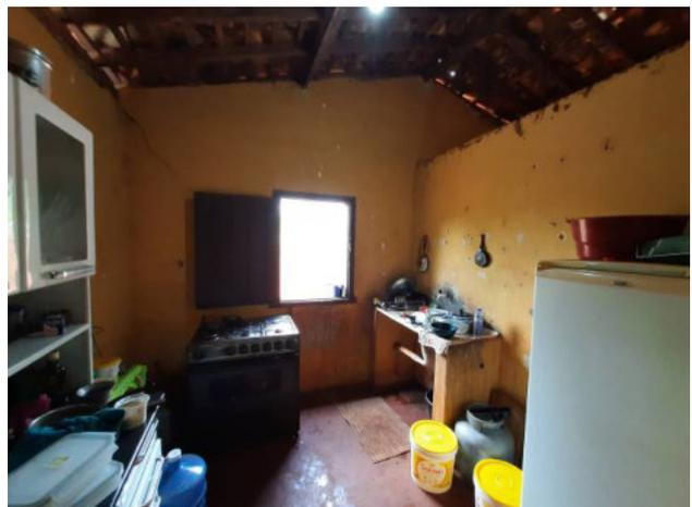
Foto 10: Detalhe da cozinha da edificação, também com piso em cimento queimado, sem forro e com esquadria de madeira.
